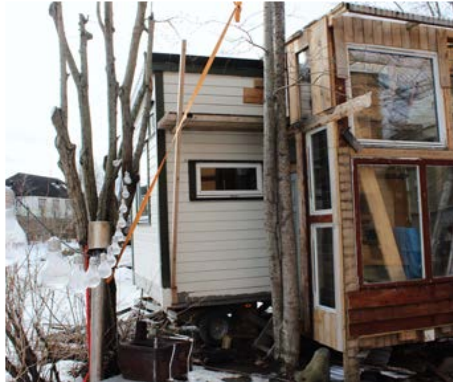
◀ Brent fasade: Huset er dekket av gjenbrukt treverk som er brent etter japansk skikk.
